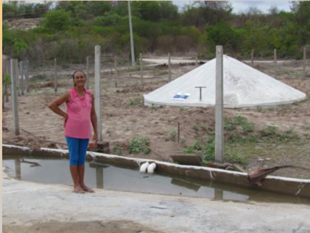
Cisterna de enxurrada, aproveitando o lajedo de pedra como área de captação
